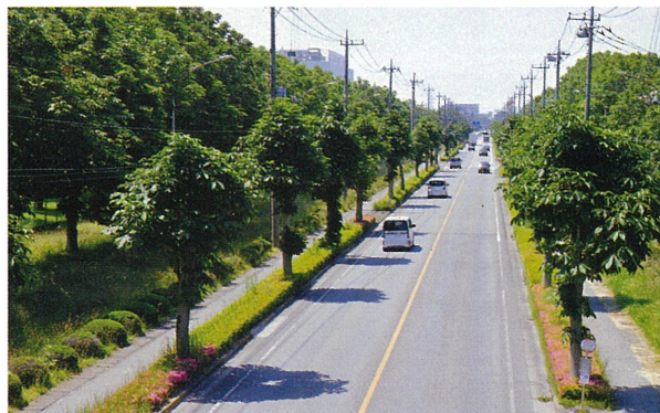
▲宇都宮市平出工業団地内（産業通り）
